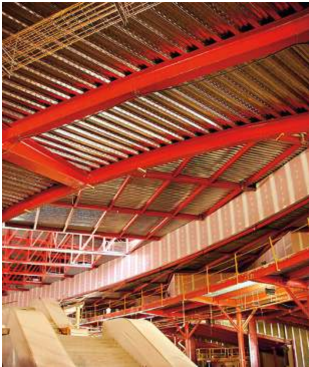
Solución acústica compuesta por chapa metálica perforada, y panel de doble densidad.
